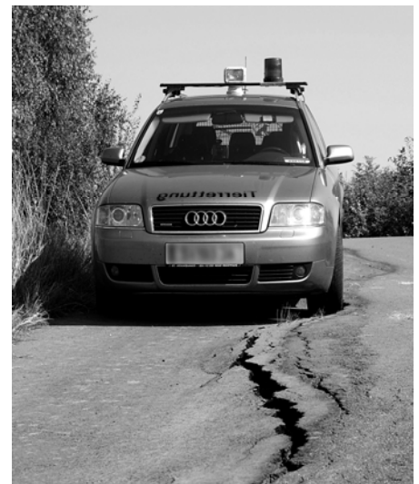
Die neu asphaltierte Hofzufahrt ist durch den Hangrutsch aufgerissen.
